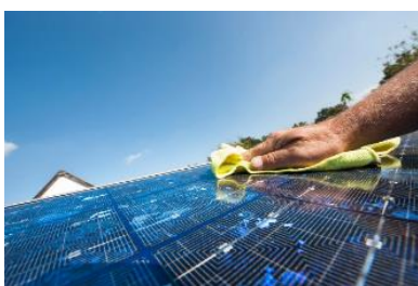
Gambar 3. Kegiatan Pemeliharaan Panel Surya
