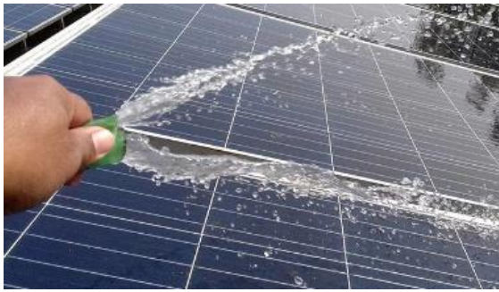
Gambar 8. Penyemprotan Dengan Tekanan Rendah
