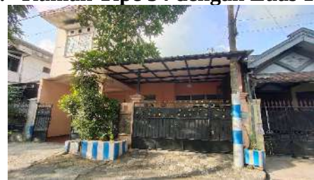
Gambar 7 Rumah Tipe 54, Jalan Simpang Emas II
