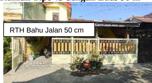
Gambar 11. Rumah Tipe 45, Jalan Alpaka
