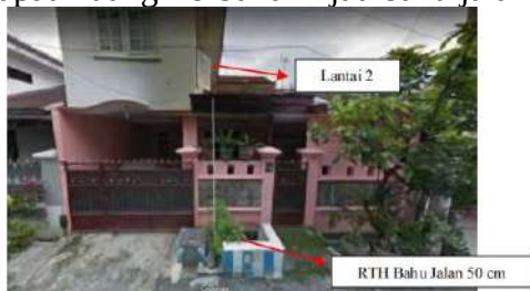
Gambar 8. Rumah Tipe 54, Jalan Simpang Emas II
