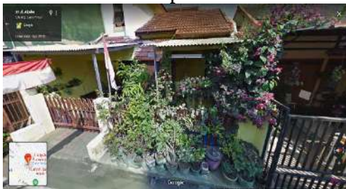
Gambar 13. Rumah Tipe 45, Jalan Alpaka
